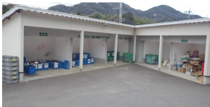
■公設分別ステーション(立花口地内)
