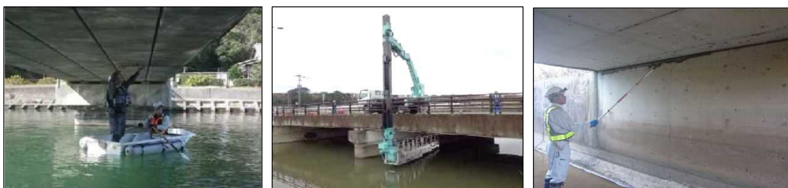
図-3 近接目視点検の様子
