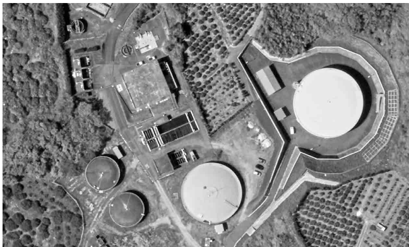
上空から見た立花浄水場
