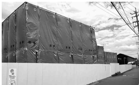
解体工事が進む雲雀ヶ丘団地
