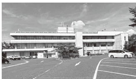
築45年経過した役場本庁舎
