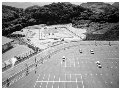
建設が進むふれあいの丘公園テニス施設
