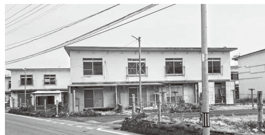
解体される雲雀ヶ丘団地
