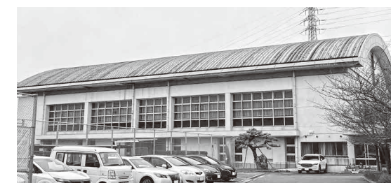
改修される新宮中体育館
