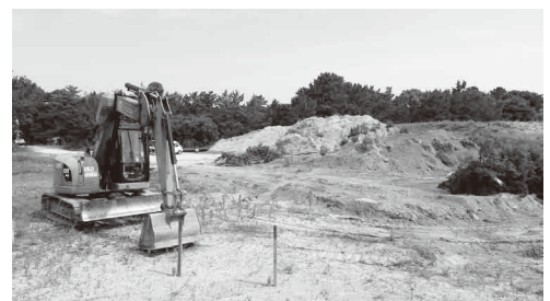
町営住宅建設予定地
