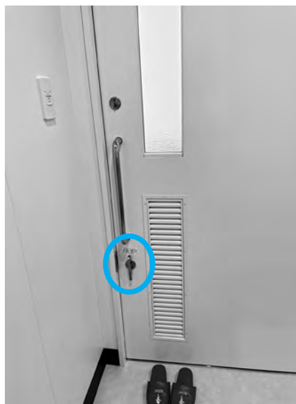
ふれあい交流館多目的トイレ 低い位置に鍵が設置されました
