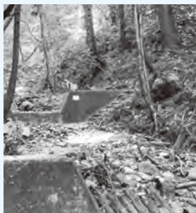
立花山登山道土砂災害 復旧工事箇所
