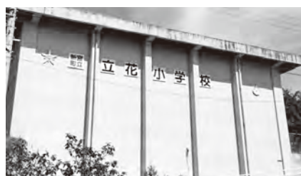
屋根・外壁の改修を予定している 立花小学校体育館
