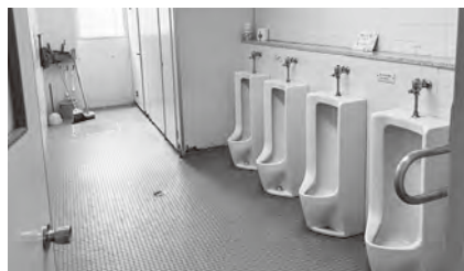
改修を予定している 新宮東小学校トイレ
