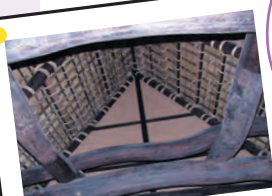
茅葺屋根の内部
