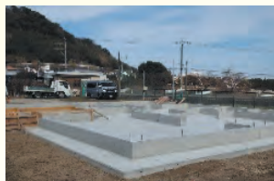
【 住宅基礎工事 】
