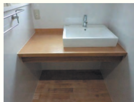
【 洗面台新調工事 】
