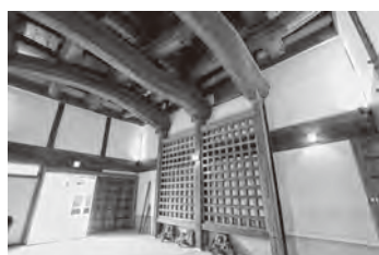
▲中に入ると大きな梁(はり)
